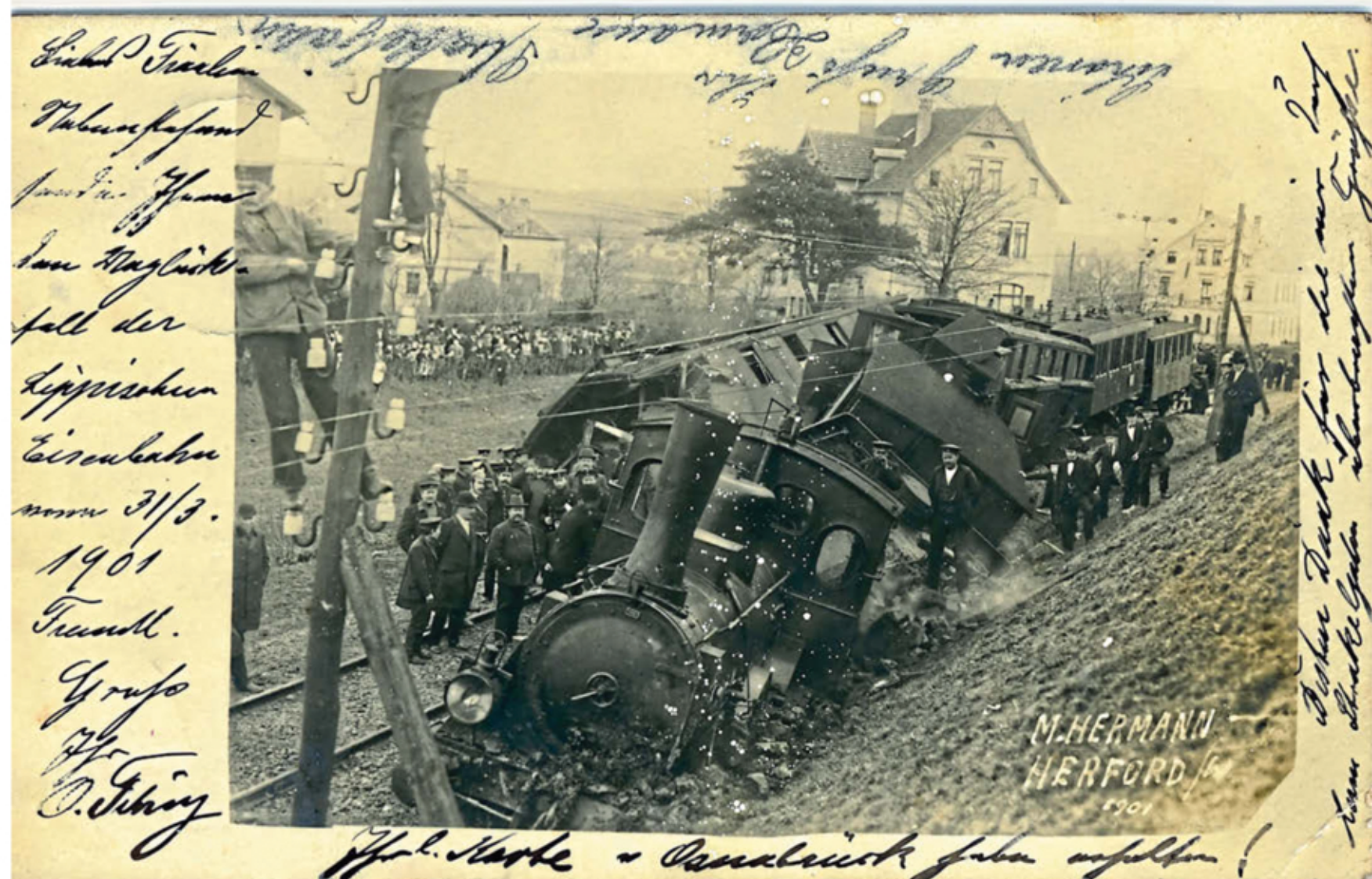
Blick von der Böschung zwischen Elverdisser und Ahmser Straße (im Hintergrund) auf die Unfallstelle am 31. März 1901. Wegen eines Gleisbruches war der Personenzug 575, von Altenbeken kommend, in der lang gezogenen Kurve entgleist. Da sich der Unfall an einem Sonntag ereignete, drängten sich bis zum Sonnenuntergang große Mengen von Schaulustigen um die Trümmer.
